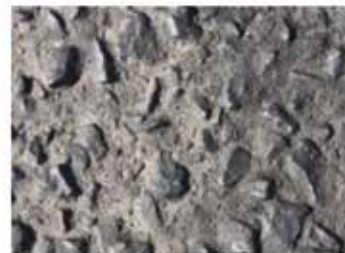
Figura 5. Aspecto superficial del Cape Seal
