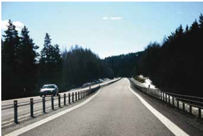
Ilustración 1. Carretera 2+1 sueca. Fuente: AEC
