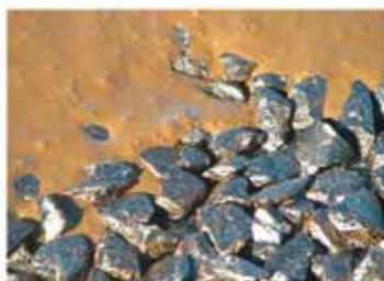
Figura 7. Detalle de distribución de la lechada asfáltica sobre el TBS en el Cape Seal
