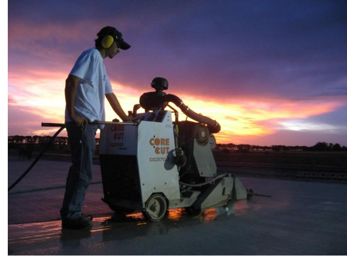
Junta Transversal de Contracción con Pasadores
