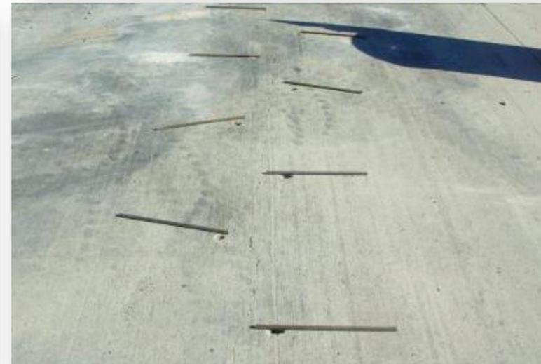
**La perforación no debe alcanzar el fondo de la losa (finaliza 1-2 cm antes)**
